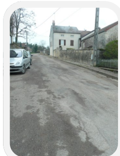
La rue de l'Eglise a été réhabilitée.
