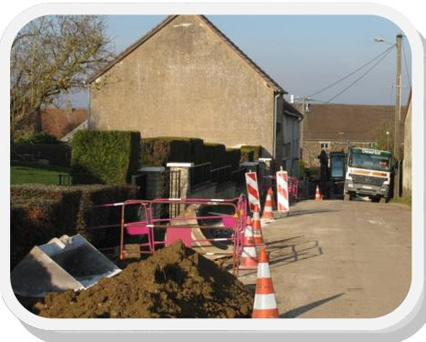
Les conduites d'alimentation d'eau route de Flacey étant de diamètre insuffisant, l'entreprise Désertot, pilotée par la Lyonnaise des Eaux, a réalisé la modification nécessaire.
