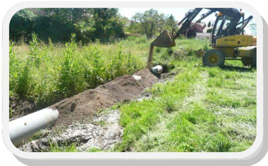
La sortie du trop-plein du la-voir a été modifiée : Quatre buses ont été mises en place et recouvertes de terre...
