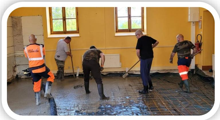
Après séchage, un isolant a été installé par Régis et Jean-Marc avant le coulage de la chape lisse.
